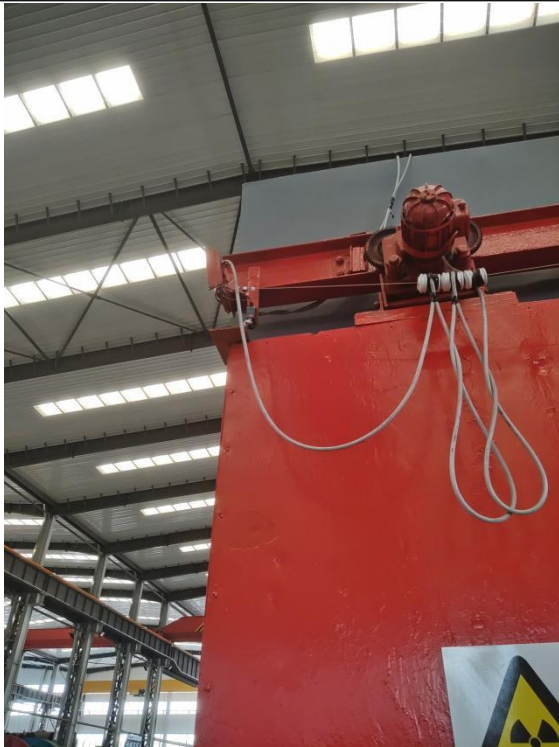
图 3-19 大管探伤室大防护门门机联锁
