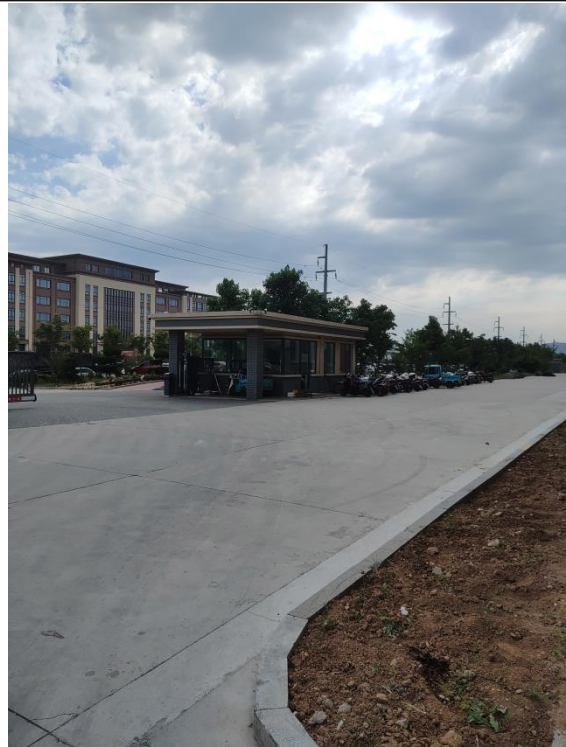
图 2-13 3620 管线探伤室北侧门卫
