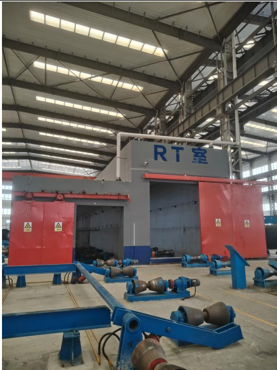
图 2-8 小管探伤室北侧大管探伤室、3620 管线探伤室
