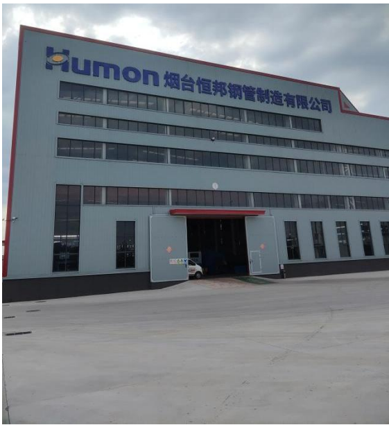
图 2-4 探伤室所在厂房
