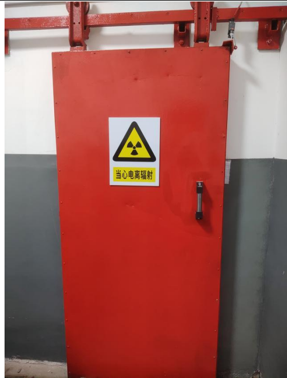
图 3-24 大管探伤室小防护门电离辐射警告标志
