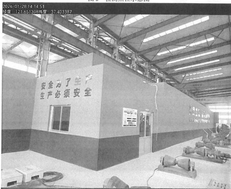
图 4 现场检测照片
