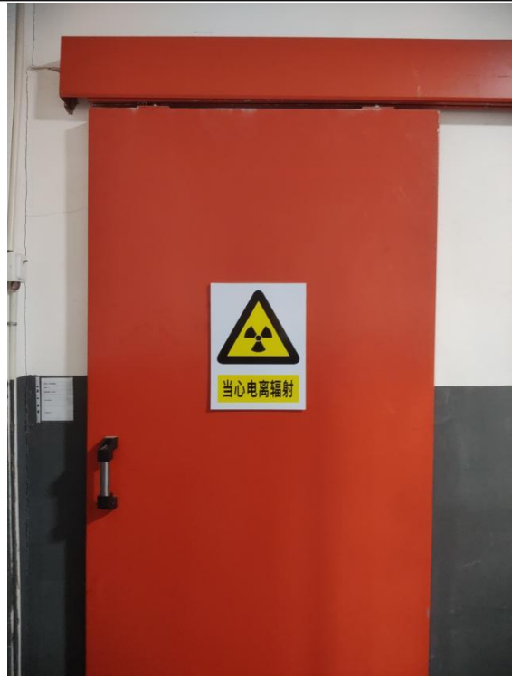
图 3-40 3620 管线探伤室小防护门电离辐射警告标志
