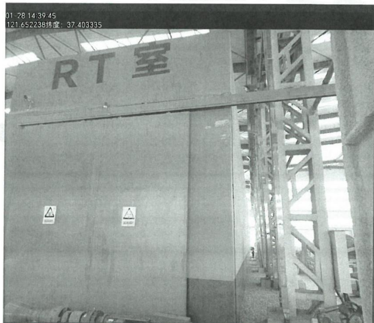
图 6 现场检测照片
