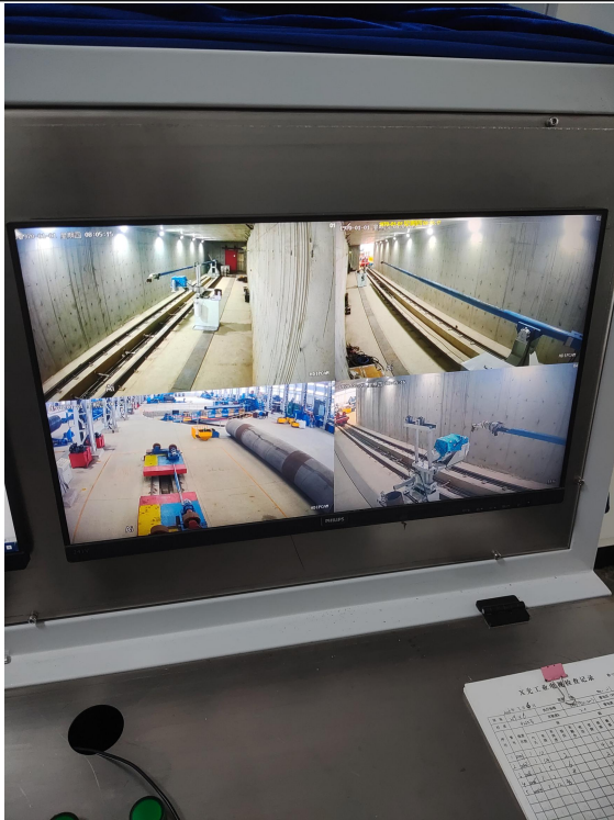
图 3-47 3620 管线探伤室操作室监控显示器
