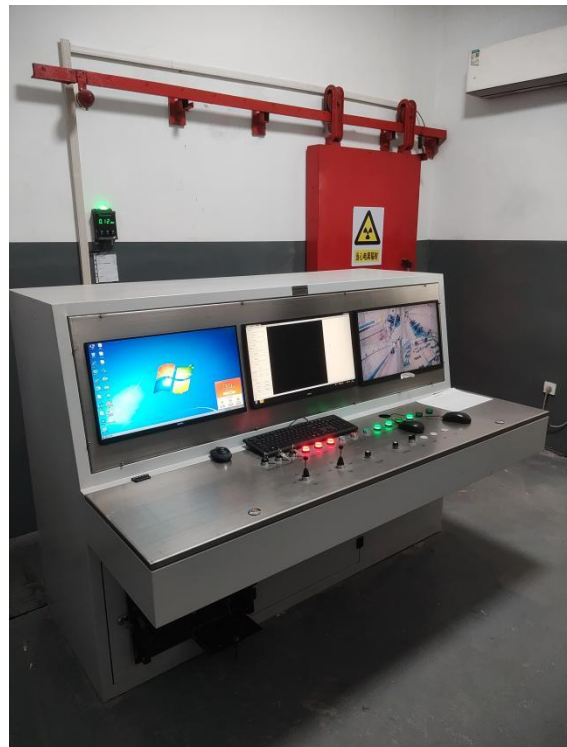
图 2-11 大管探伤室、3620 管线探伤室西侧操作室
