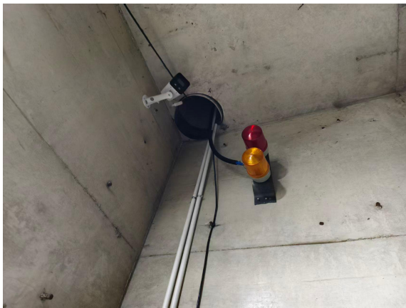
图 3-6 曝光室内信号警示装置
