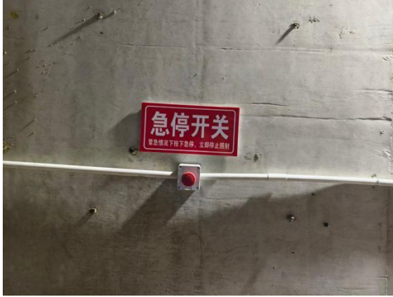
图 3-10 曝光室内紧急停机按钮 4
