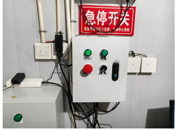
图 3-11 曝光室紧急停机按钮
