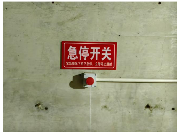
图 3-9 曝光室内紧急停机按钮 3
