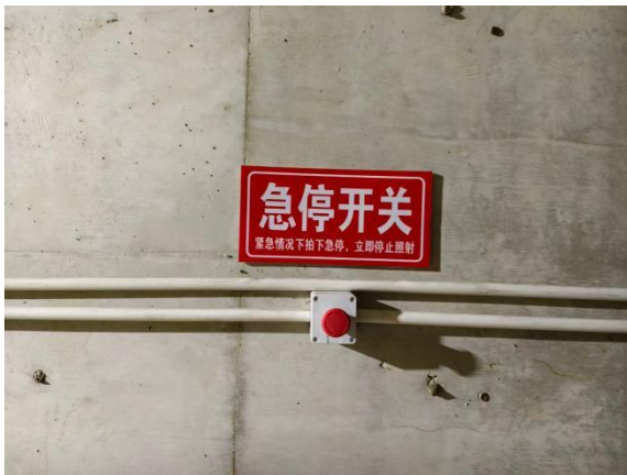
图 3-8 曝光室内紧急停机按钮 2
