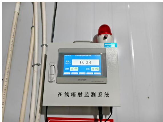
图 3-16 固定式剂量报警装置显示器
