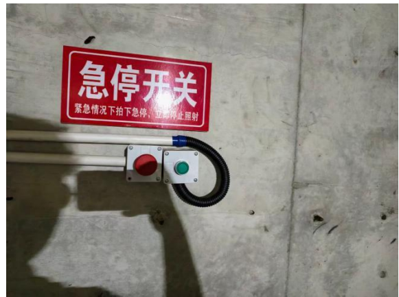
图 3-7 曝光室内紧急停机按钮 1
