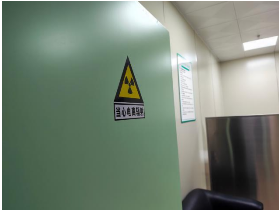
图 3-7 PET-CT 留观室外电离辐射警告标志
