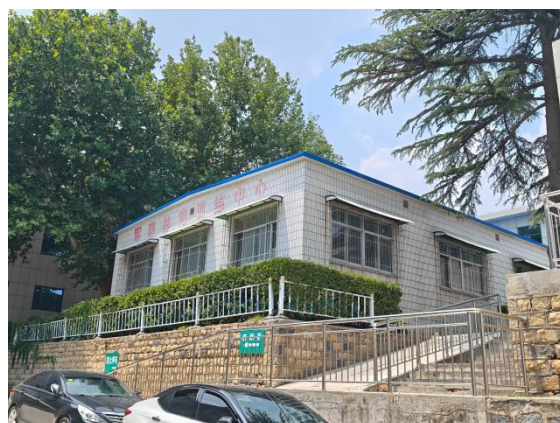
图 2-10 一层核医学工作场所西北侧体能训练中心
