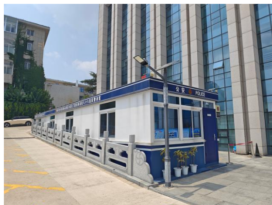
图 2-8 一层核医学工作场所南侧警卫值班室
