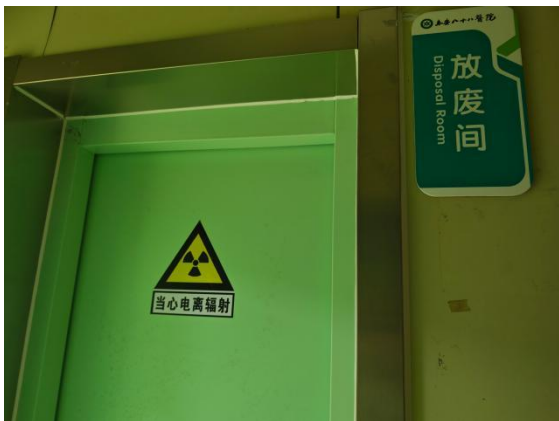
图 3-24 放废间外电离辐射警告标志
