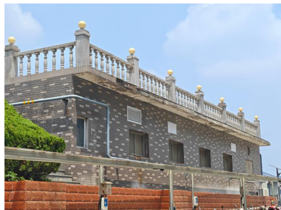
图 2-14 一层核医学工作场所东北侧配电中心
