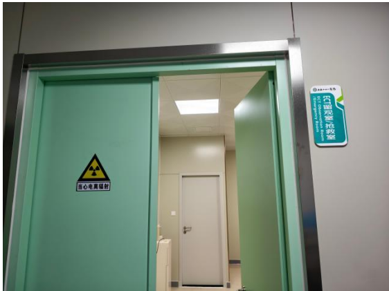
图 3-5 SPECT-CT 留观室外电离辐射警告标志
