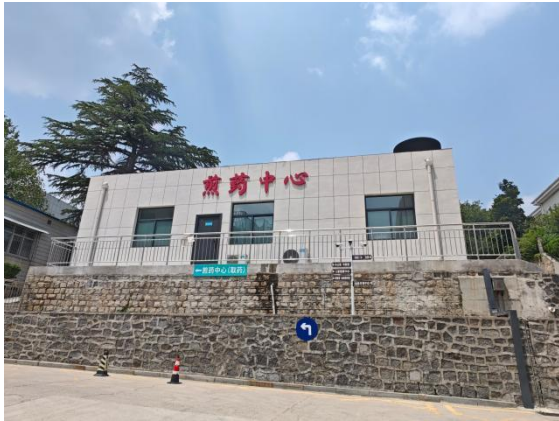
图 2-11 一层核医学工作场所北侧煎药中心
