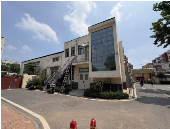
图 2-21 DSA 介入二室东北侧消毒供应中心
