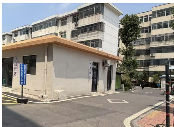
图 2-17 DSA 介入二室北侧商铺
